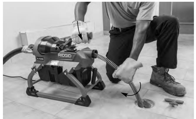
Figure 11A – Embrayage engagé, câble en rotation, acheminement du câble dans la canalisation
