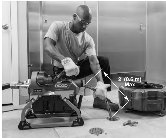
Figura 9 – El operario en posición de trabajo
