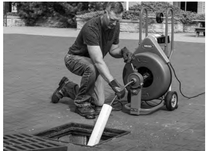
Figure 10 – Exemple de prolongation de la conduite pour l'amener à moins d'un mètre de la sortie de câble
