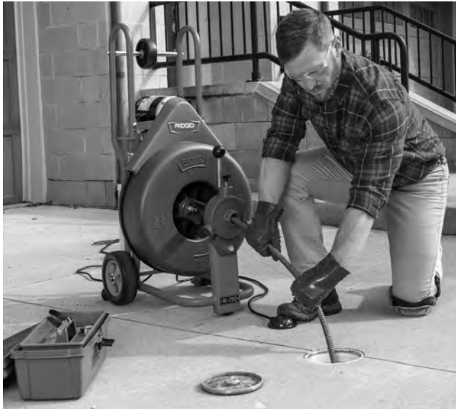
Figure 12 – Avancement manuel du câble en position de travail
