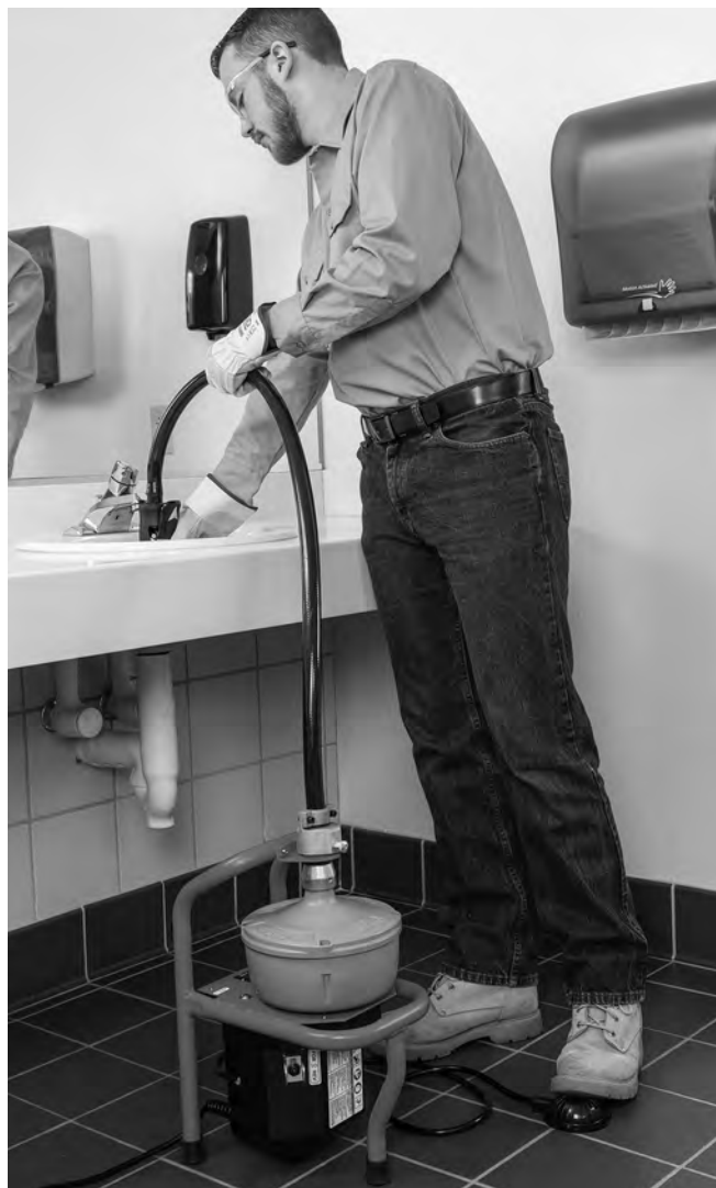
Figura 11 – Empleo de la K-40 con AUTOFEED
