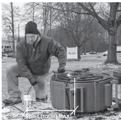
Figura 10 – El operario en posición correcta para trabajar
